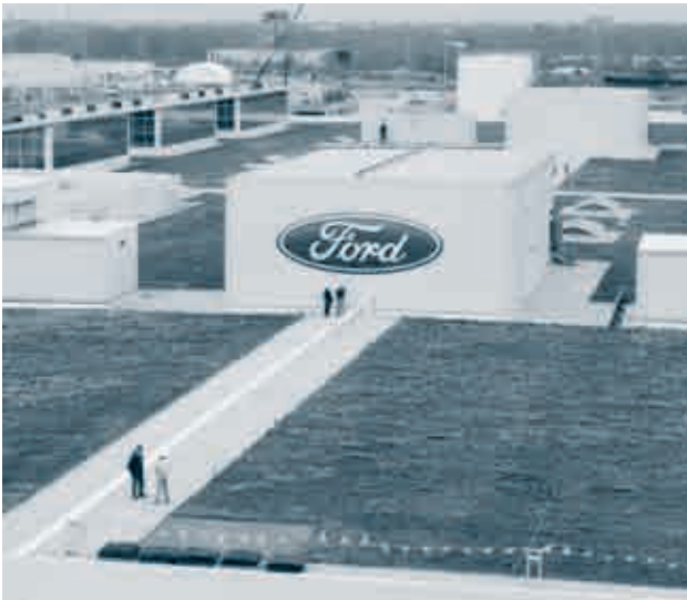
La colaboración entre los socios de la cadena de valores también puede beneficiar a la comunidad. En la fábrica de ensamblaje reactivada de Ford Motor Company que se encuentra en el Ford Rouge Center al sur de Detroit, una asociación entre la empresa fabricante de automóviles y la Universidad Estatal de Michigan crea un techo vivo de vegetación para eliminar los contaminantes del suelo, absorber el bióxido de carbono y, producir oxígeno y proteger el interior, al mismo tiempo que se controla la corriente de agua de las tormentas.
